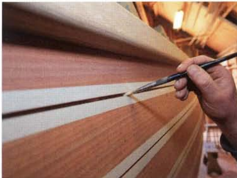
Nadat de zijkanten van de naden zijn afgeplakt kan een sealer worden aangebracht, zodat het rubber beter zal hechten.
