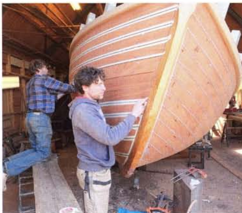
Het overtollige rubber is verwijderd. De bakboord kant is schoon, aan sb wordt het plakband verwijderd.
