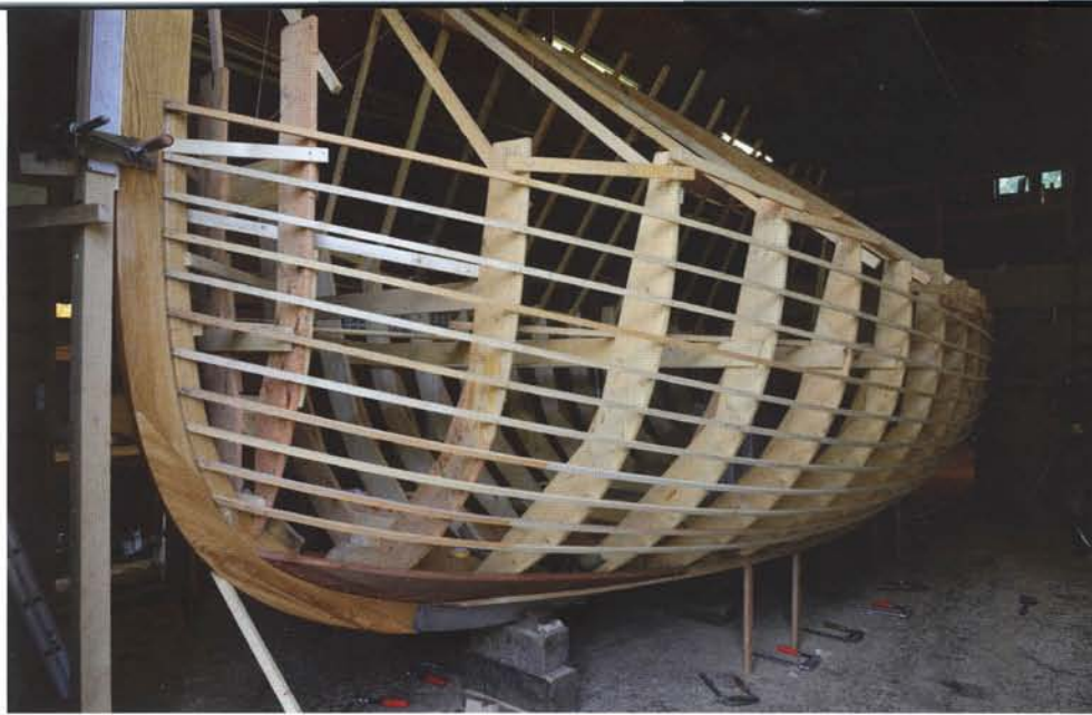
De bouwspanten staan opgesteld. Met strooklatten wordt het verloop van de gangen bepaald.
