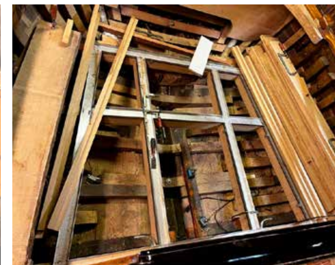
Schouten plaatste een nieuw rvs-frame in de waterdichte kuip.
